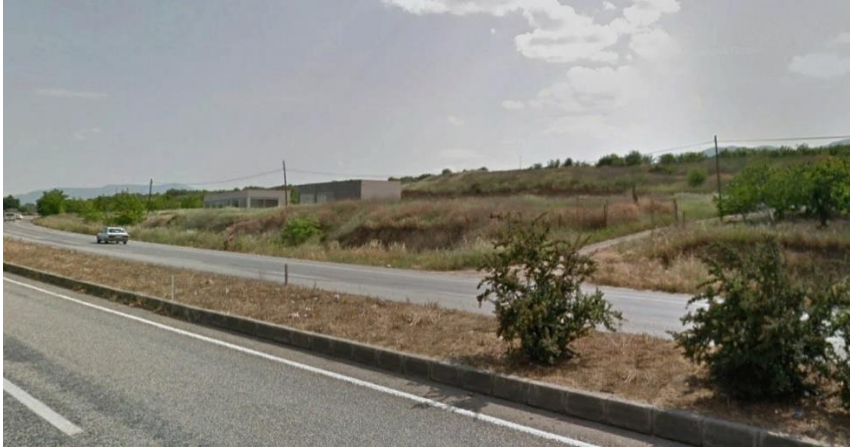
Planlama Alanının Turgutlu-Manisa Karayolunun Kuzeyinden Görünümü
